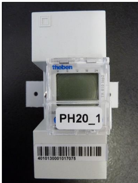
Spínací hodiny Theben TR612, od roku 2018 s označením kódu
